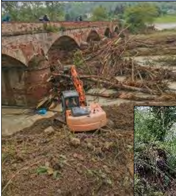
Pulizia vegetazione, rimozione accumuli e occlusioni
