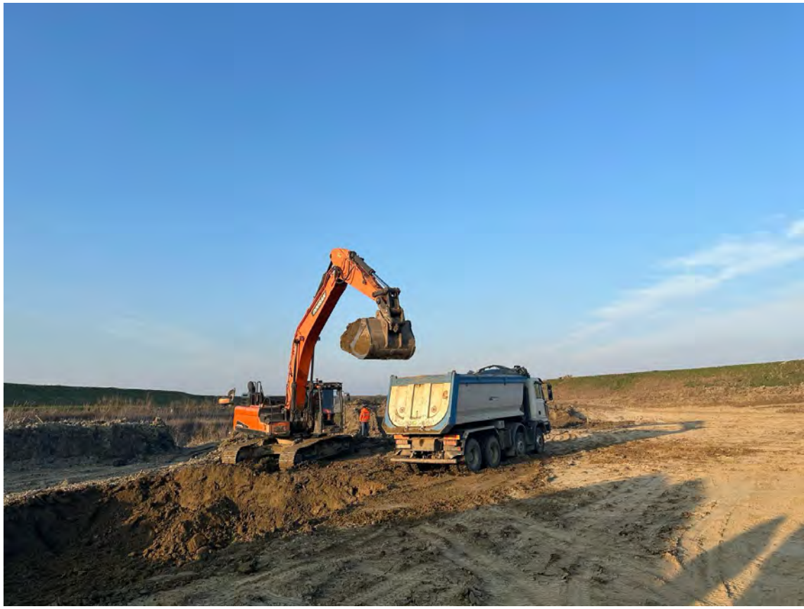
Fiume Santerno tra Mordano (BO) e Bagnara di Romagna
